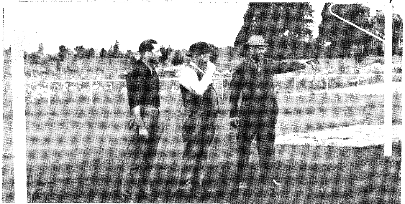
Skepptunas nya idrottsplan inspekteras av fr. h. kommittéordf. Holger Höglund, entreprenören C. A. Hedman och eldsjälens i Skepptuna IK Stig Elfstrand
